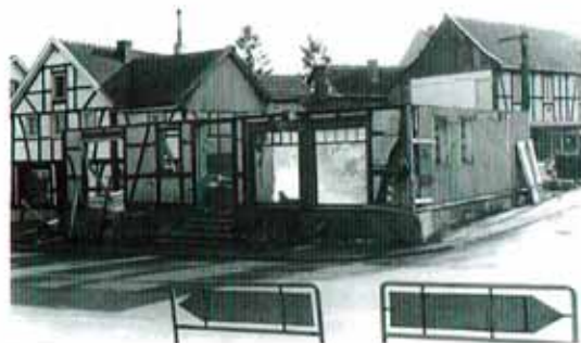
Abriss der Gaststätte „Zur alten Post“ an der Kreuzung Siegburger Straße
