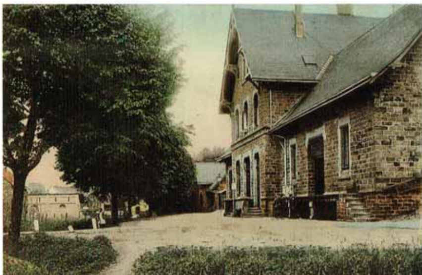
Vorderseite des Bahnhofs von Nordwesten. Das Bild stammt aus der Zeit um 1920
