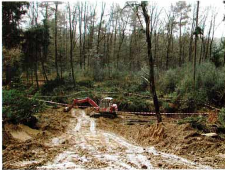
Neu angelegte Zufahrt zum Tagesbruch. Zum Zeitpunkt dieser Aufnahme ist der Bruch bereits fast vollständig mit Sand und Kies verfüllt.
