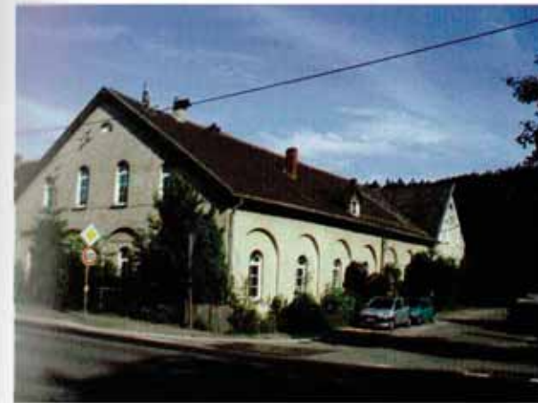
Erzaufbereitung Immekeppel, heutiger Zustand. Wohnhaus im Bereich der Lindlarer Straße
