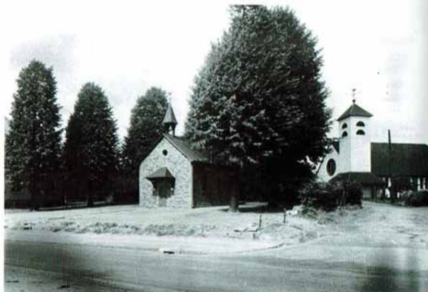
Kapelle nach Beendigung der Arbeiten an der Giebelwand im Jahre 1939. Im Hintergrund die 1936/37 errichtete neue Kirche, heute Pfarrsaal. Der Turm wurde anlässlich der Umwidmung zum Pfarrsaal abgerissen.
