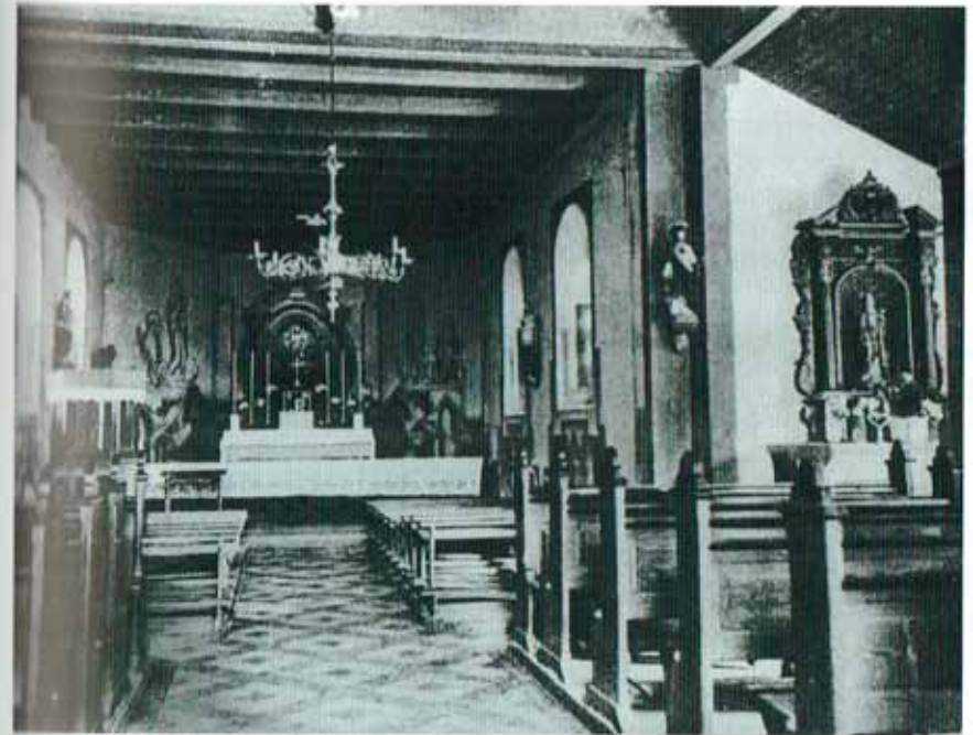
Innenansicht der Kapelle mit Erweiterungsbau vor dem Abbruch
