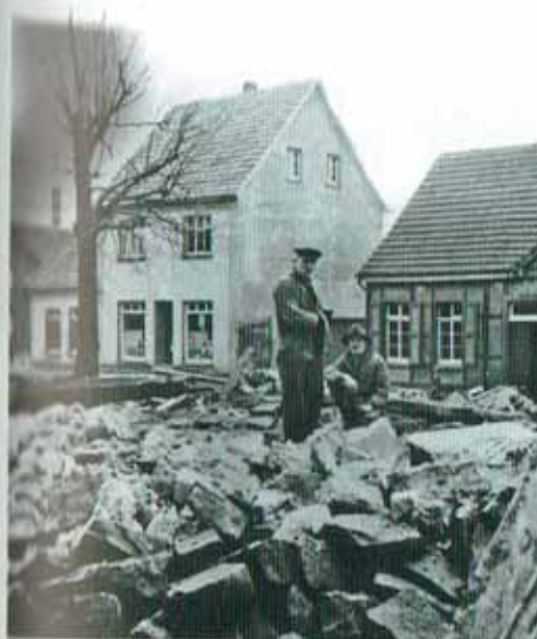
Theodor Becker und Heinrich Wasser nach Abbruch des Erweiterungsbaus.
