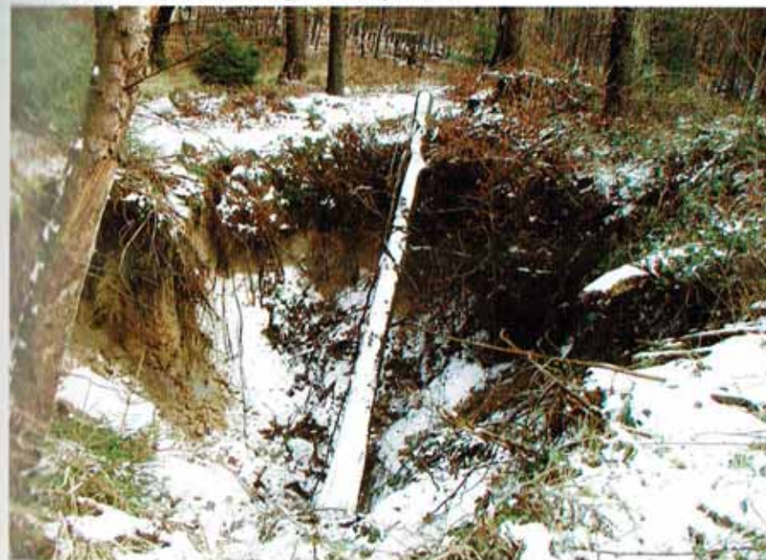
Tagesbruch am ehemaligen Maschinenschacht der Grube Apfel im Februar 2006
