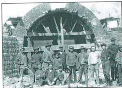
Bau eines Viaduktes
