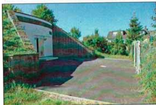
Der Hochbehälter Neuenhausen garantiert 1000 m³. Wie bei den anderen Hochbehältern wird die Schieberkammer besonders gepflegt und gewartet. Foto: Pütz
