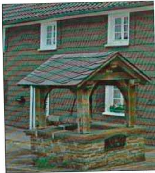
Ein schönes Beispiel eines früher genutzten Trinkwasserbrunnens ist dieser schön gestaltete in Marialinden am Kirchplatz. Foto: Pütz
