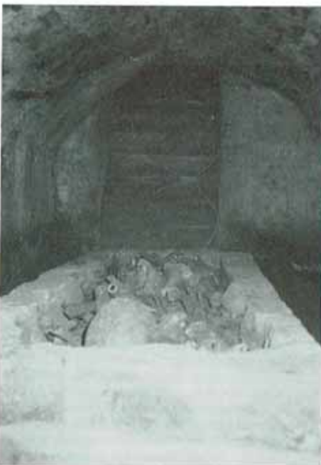
o. Blick vom Innern der Gruft auf die freigelegte Treppe (Tonnengewölbe gut erkennbar).
