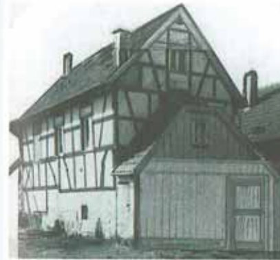
Abb. 1 Klassenräume der ehemaligen Mädchenschule in Vilkerath im Anbau an der Rückfront der früheren Gastwirtschaft Fischer - bis 1882
