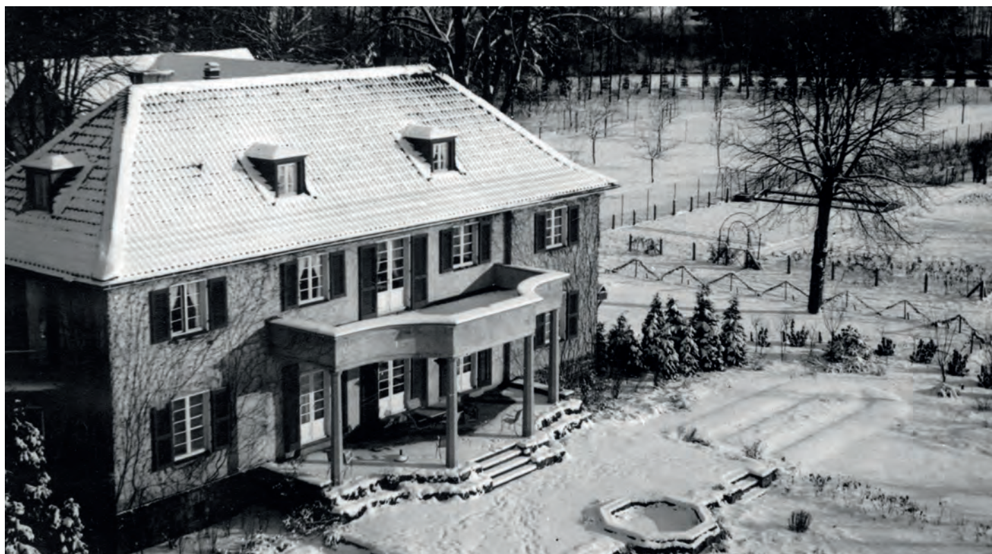
Abb. 49: Das fertiggestellte Gutshaus im Winter 1936/37 mit Terrasse und Springbrunnen.
