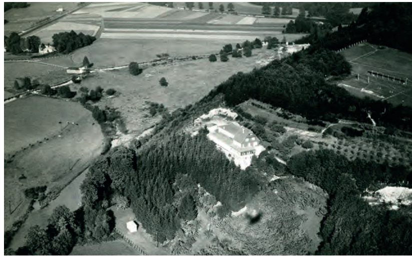
Abb. 75: Das erweiterte Petersheim, Luftbild aus dem Jahr 1934, in der unteren linken Bildecke rechts neben dem Verlauf der Agger ist ein weißes Pumpenhaus zu sehen. Von hier aus wurde das Schwimmbad im Petersheim mit Aggerwasser versorgt.
