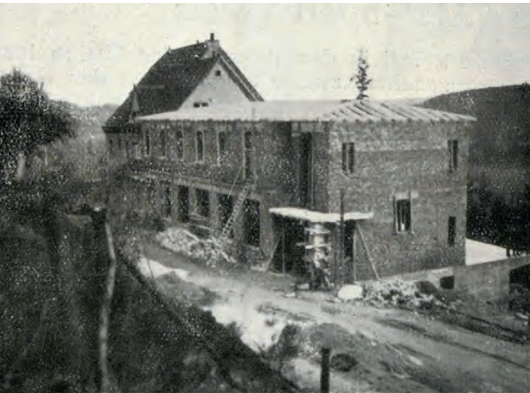
Abb. 74: Das neue Petersheim“, der Anbau an das vorhandene Gebäude des ehemaligen Helenenhofs im Rohbau.
