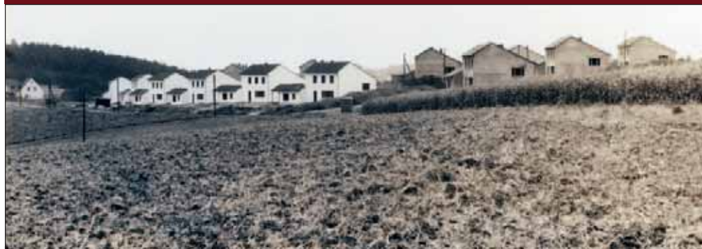
Teilweise fertiggestellte Häuser des Siedlungsteiles Neuhurden, 1960 (Quelle: Hanna Bakalorz)
