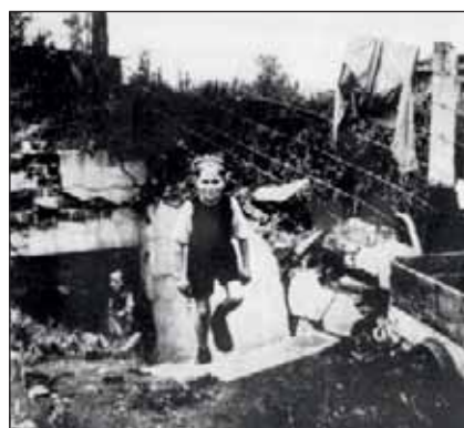
Von zerstörten Häusern bleiben oft nur die Keller als Wohnraum übrig (Foto: Institut für Stadtgeschichte Gelsenkirchen)
