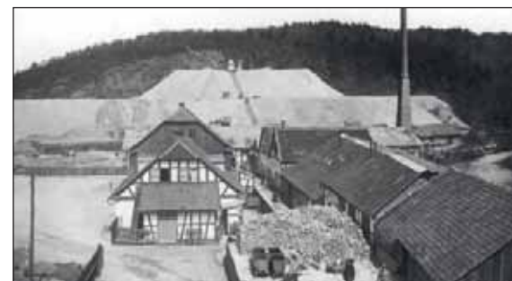
Die Steinenbrücker Aufbereitung um 1890. Im Hintergrund sieht man den Schrägaufzug, über den die Waschberge 85 auf Halde gefahren wurden. In der Bildmitte lagert handverlesenes Erz zum Abtransport in die Verhüttung. Links stehen die Häuser Olper Straße 129 und 131. (Sammlung Siegfried Raimann)
