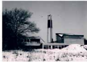
Rohbau des Pfarrhauses mit fertiggestellter Kirche, Winter 1968 (Quelle: Dieter John)
