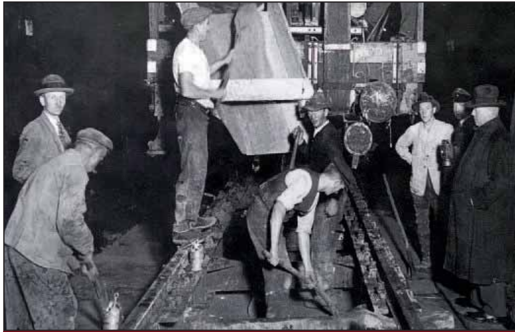
Reparaturarbeiten im Honrath Tunnel nach dem Zweiten Weltkrieg (Foto: Stadtarchiv Overath)
