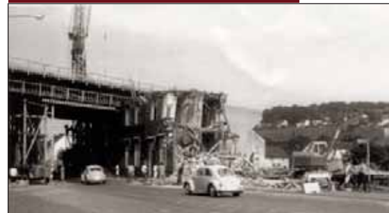
Bereits 1968 wurde die Autobahnbrücke über die damalige Bahnstraße gebaut. Der Abriss des Bahnhofgebäudes war noch nicht beendet, als der Brückenbau sich bereits über die Straße vorschob (Quelle: Pfarrarchiv St. Maria Himmelfahrt, Untereschbach).
