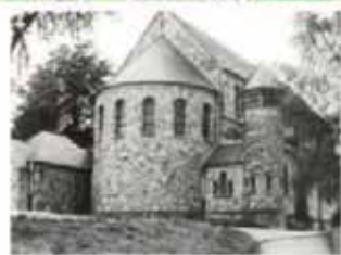
Die Kirche St. Barbara in Steinenbrück nach ihrer Fertigstellung (Foto: Sammlung Raimann)
