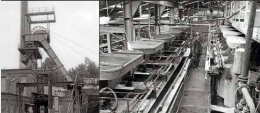
Foto links: Förderturm und Einrichtungen am Hauptschacht, Lebensader des Bergwerks. Foto rechts: Flotationsanlage mit Zellen in der Erzaufbereitung (Fotos: Sammlung Hans Hoff)
