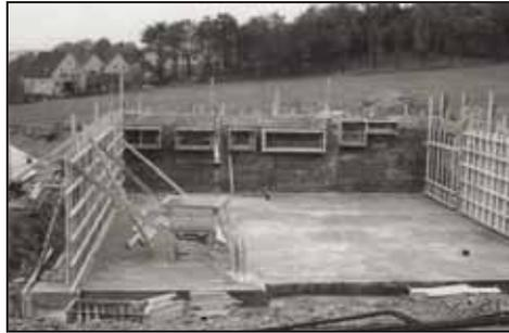
1963 Bodenplatte und Kirchenwände werden gegossen (Quelle: Dieter John)
