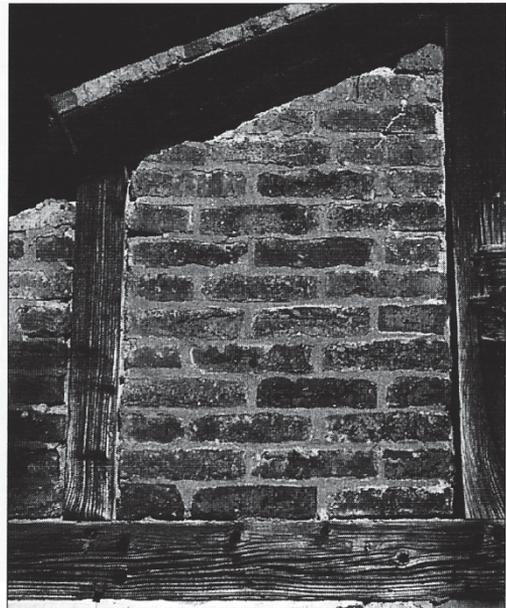
Abb. 16: Scheidehaus von Grube Nikolaus, Giebelwand. Hier wird die typische Bauweise der Betriebsgebäude der Bergwerksanlagen in der zweiten Hälfte des 19. Jahrhunderts sichtbar, und zwar Holzfachwerk mit Ziegelsteinmauerwerk (Foto 1998)
